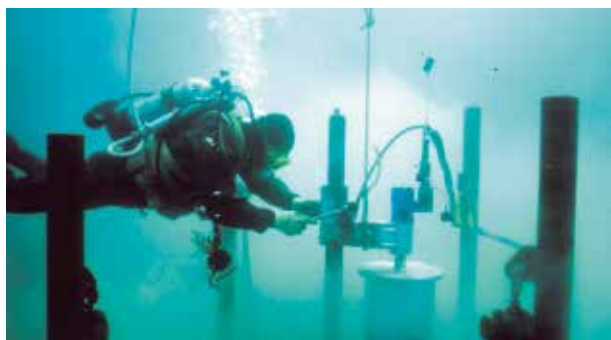
水中にあるコンクリート面に穴を開ける為、油圧コアドリルを使用して削孔します。
