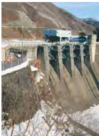
施工事例(蘭原ダム)
