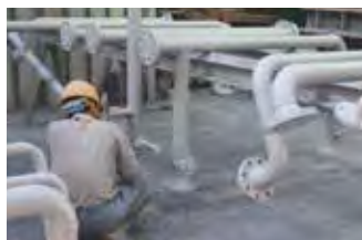
作業風景(能美工場)
