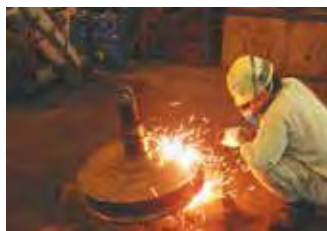
ガス切断作業
