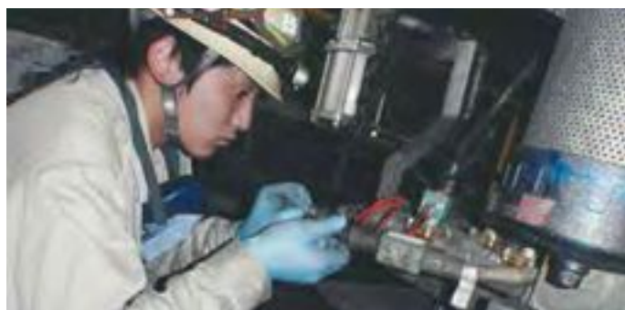
電気配線工事
